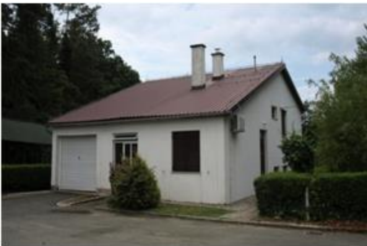
Slika 2. Upravna zgrada, ulaz u prizemnu etažu (snimila Vida Pust Škrgulja, 16. 6. 2015.)
