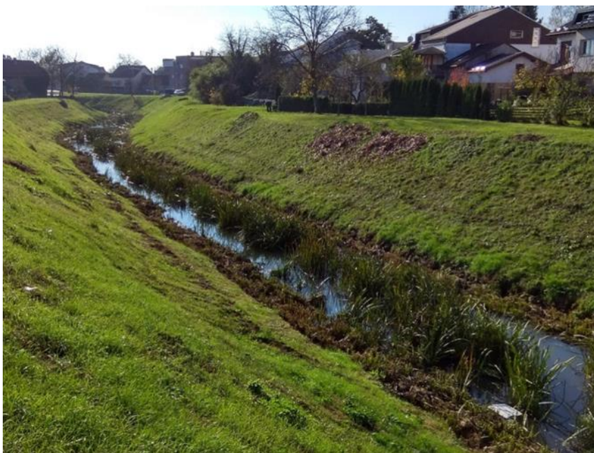
Slika 1-5: Korito rijeke Lonje na području Ivanić-Grada u postojećem stanju
