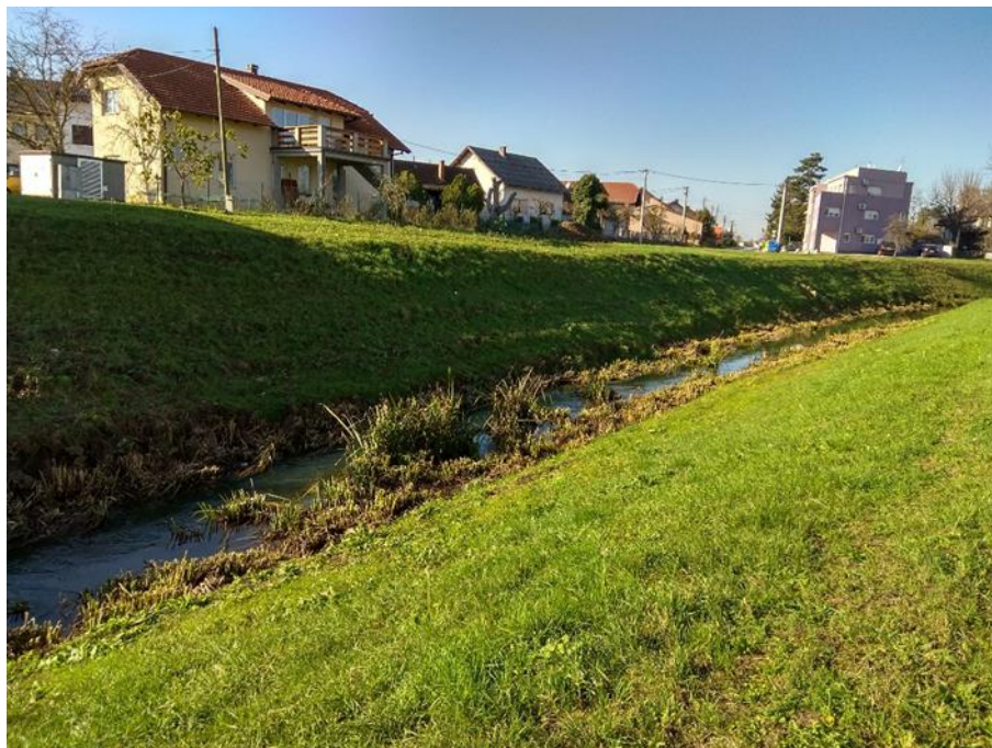
Slika 1-6: Postojeće stanje na mjestu budućeg praga na stacionaži 6+276
