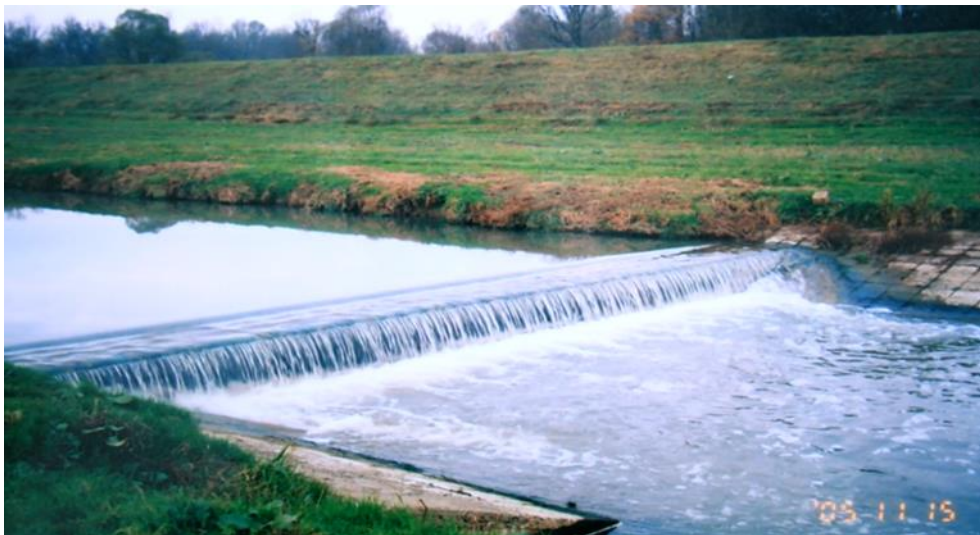
Slika 1-3: Fotografije praga na Spojnom kanalu kod kanala Lipnica u suhom i potopljenom stanju
